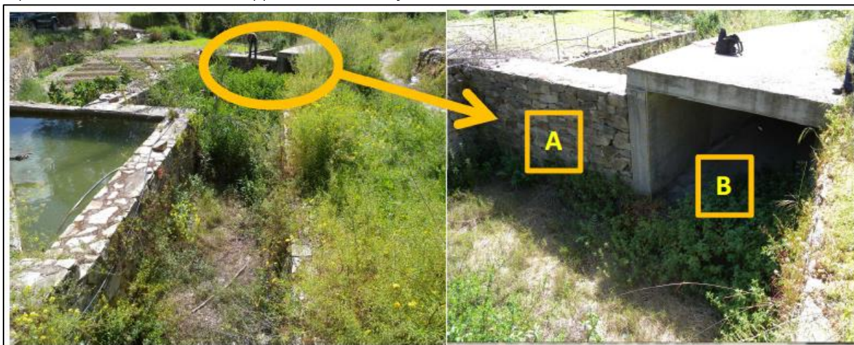
Figura 7 – Imbocco del canale diversivo (B) del rio Funtana Manna la cui testata è presidiata dal muro (A).
