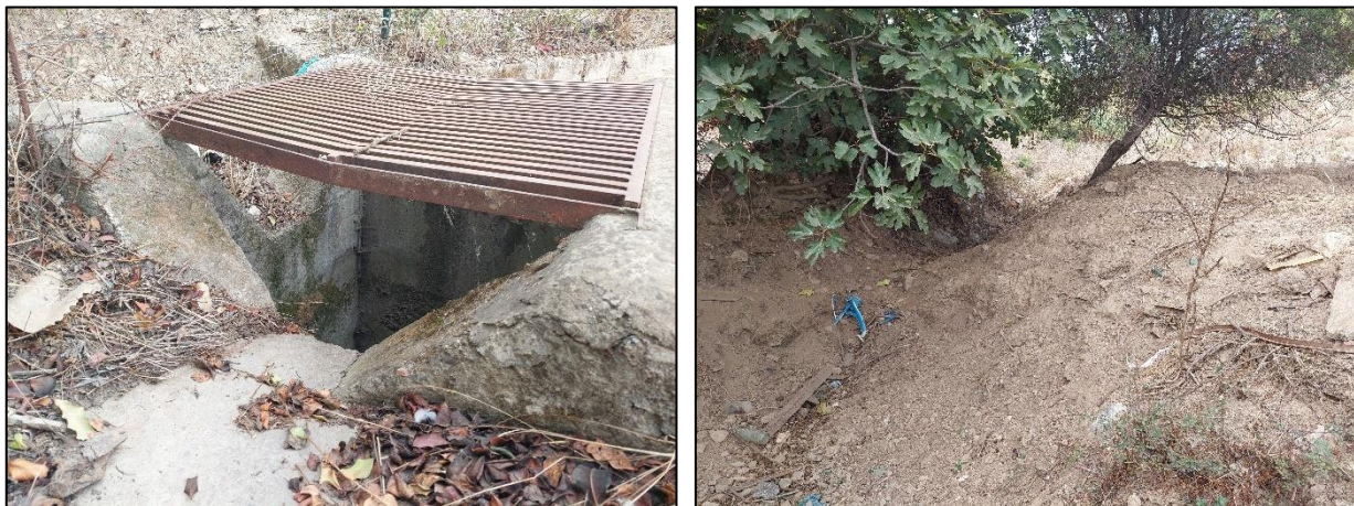
Figura 28 – Imbocco del tratto tombato del Funtana 'E Si (sinistra) e sezione di deflusso appena a monte.
