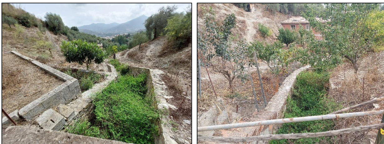
Figura 12 – Folta vegetazione arbustiva ostruente le sezioni del canale del tronco di valle del Funtana Manna.
